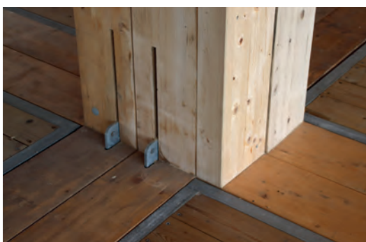
De gepatenteerde connector die het raamwerk van glulam en de zwaarlastvloeren bij elkaar houdt en snel weer los te maken is.
